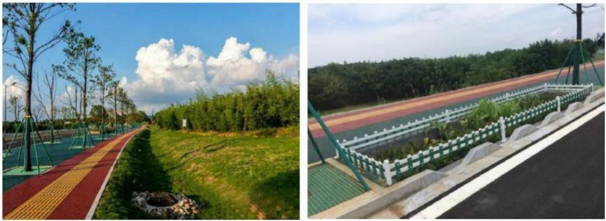
图 11.3.2-2 新建道路低影响开发雨水系统示意图
