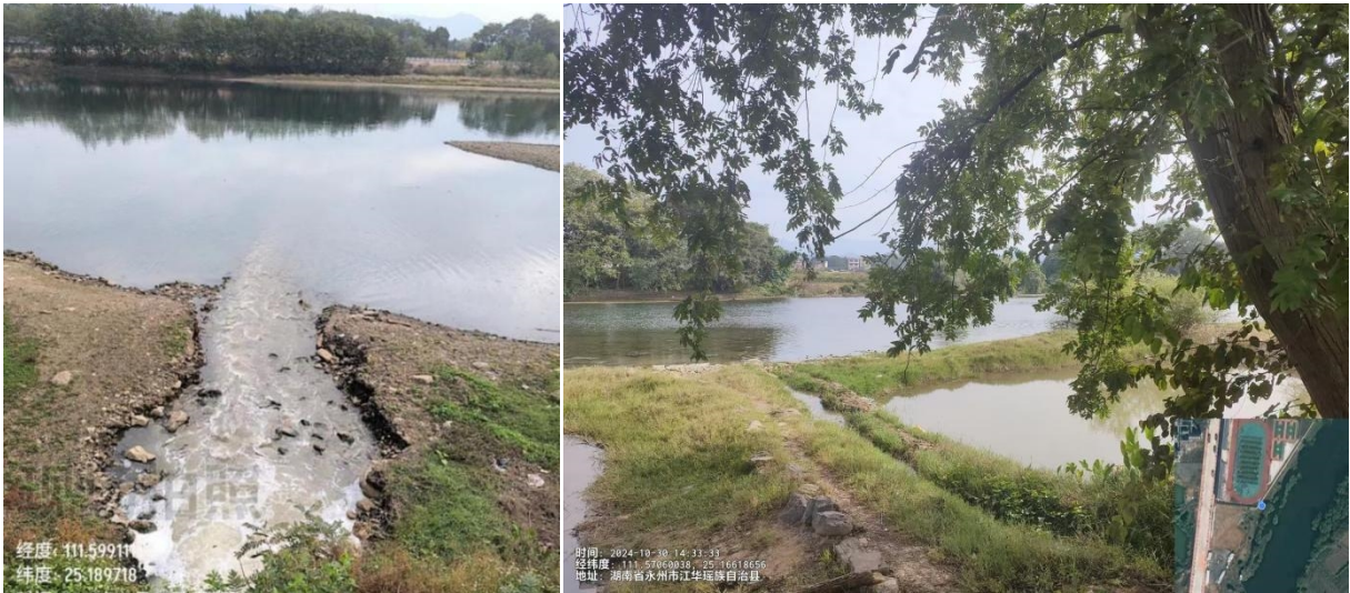
图 3.3-2 现状西河排口
