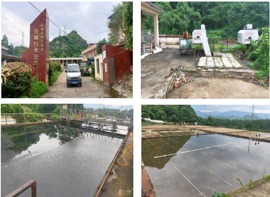
图 3.2.4-1 江华瑶族自治县第一污水处理厂工程现状图
