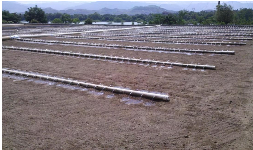
图 3.2.4-2 污水厂的快速渗滤系统
