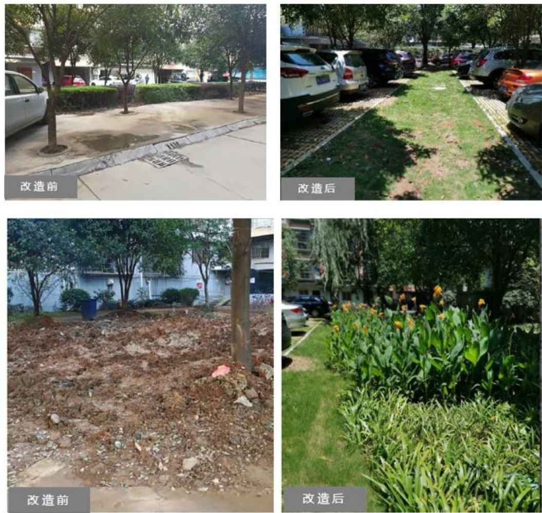
图 11.3.1-4 老旧小区低影响开发雨水系统改造对比图
