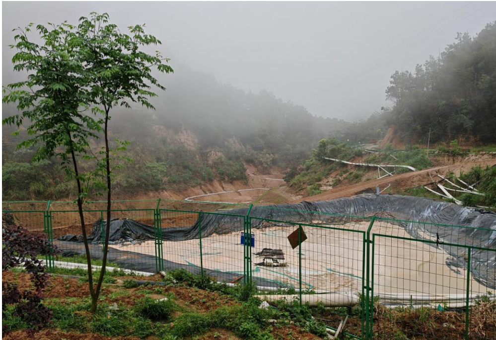
照片 5-7 大观塘铁矿部分露天坑作为矿山积水池，未进行恢复
