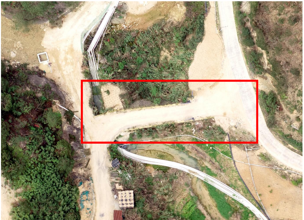
照片 5-55 二工区北部入口处的扎头源冲沟拦洪坝遥感影像
