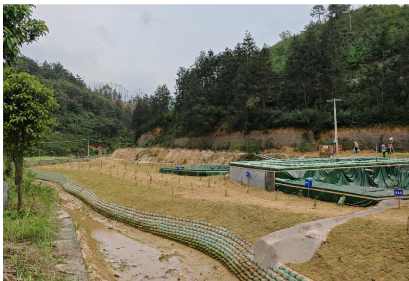
照片 5-38 生态袋挡土墙
