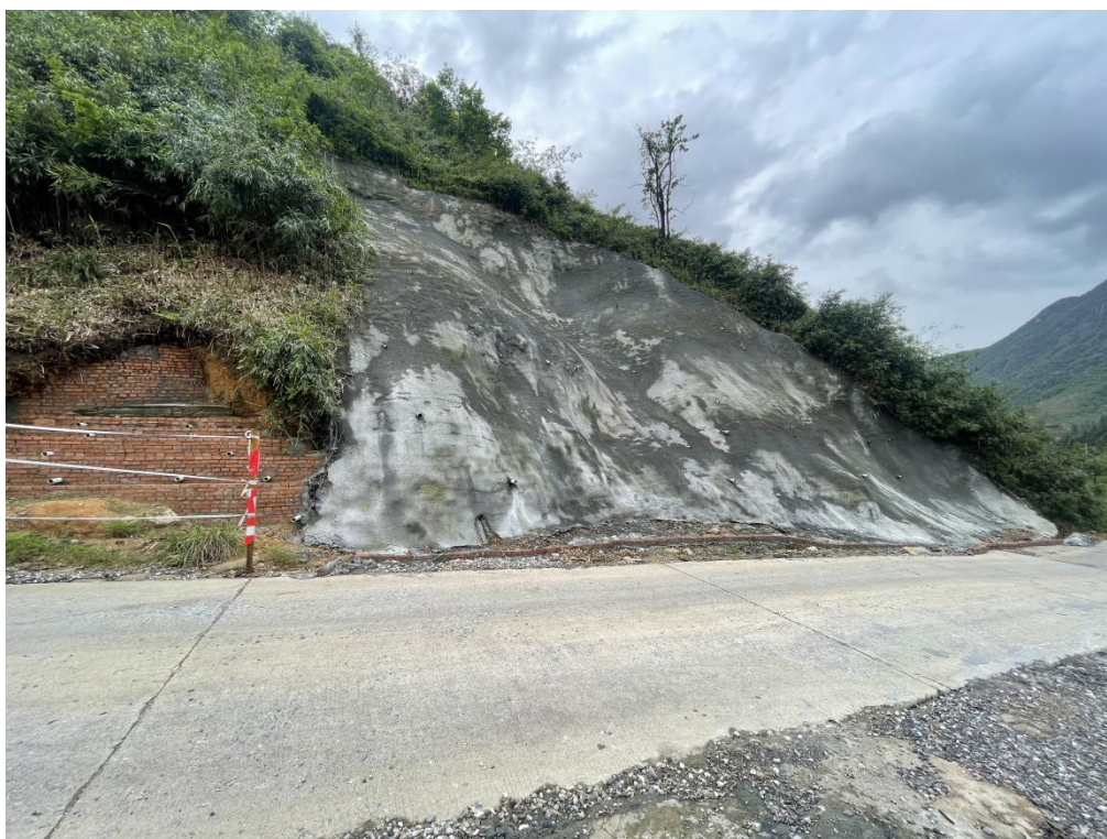
照片 5-23 四车间出入口边坡滑坡（HP2）挂网喷浆
