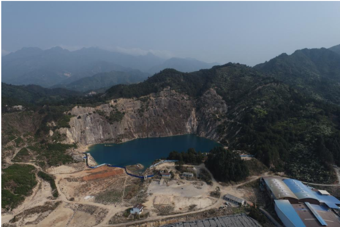
照片 5-58 新铺矿段原高岭土矿民采地段露采坑及前缘工业广场
