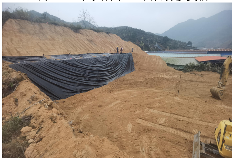
照片 5-32 扎头源表土堆放场修复中
