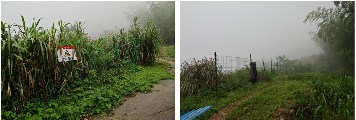
照片 5-25 大观塘铁矿采坑周边围栏及警示牌
