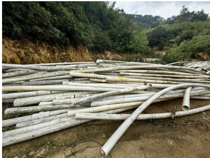
照片 5-40 拆除废弃管道
