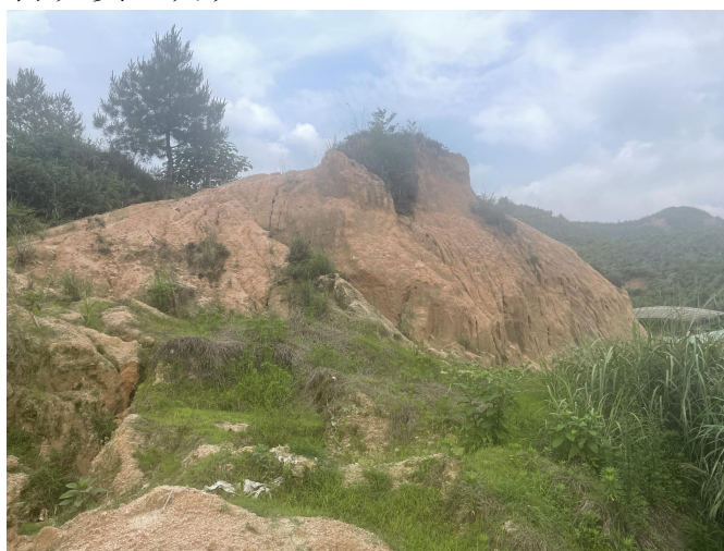
照片 5-31 扎头源表土堆放场修复前
