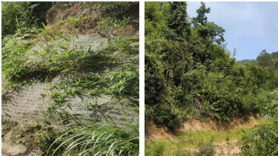
照片 5-12 导流孔平台边坡椰丝毯、平台植树种草还绿工程
