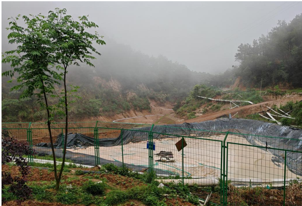
照片 5-50 大观塘铁矿南部露采坑作为矿山积水池，未进行恢复
