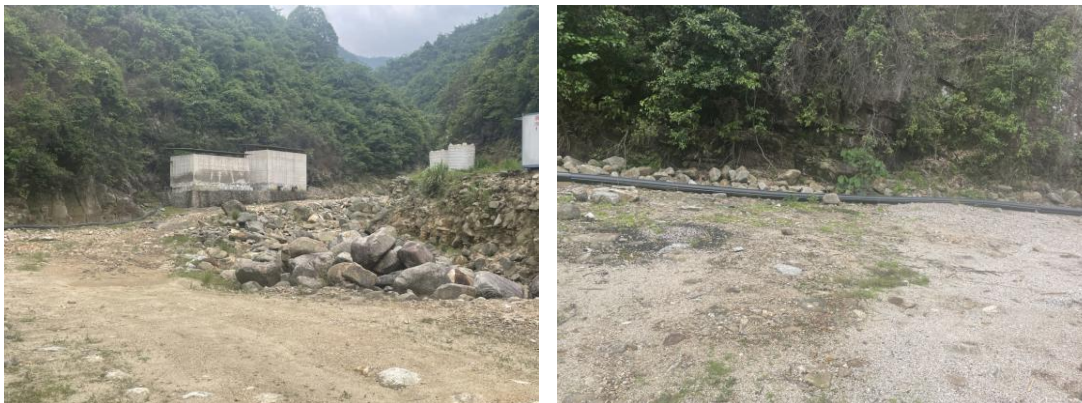
照片 5-21 腊面山村、大干头村生活用水引水工程蓄水池、管网
