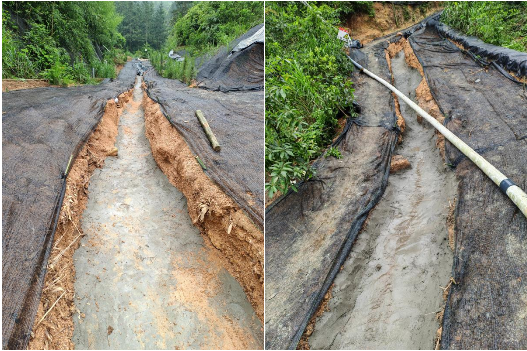
照片 7-2 已对截排水沟修复
