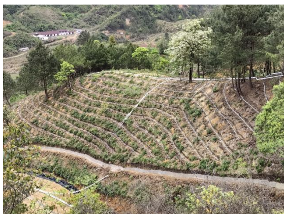
照片 5-17 采矿场避水沟
