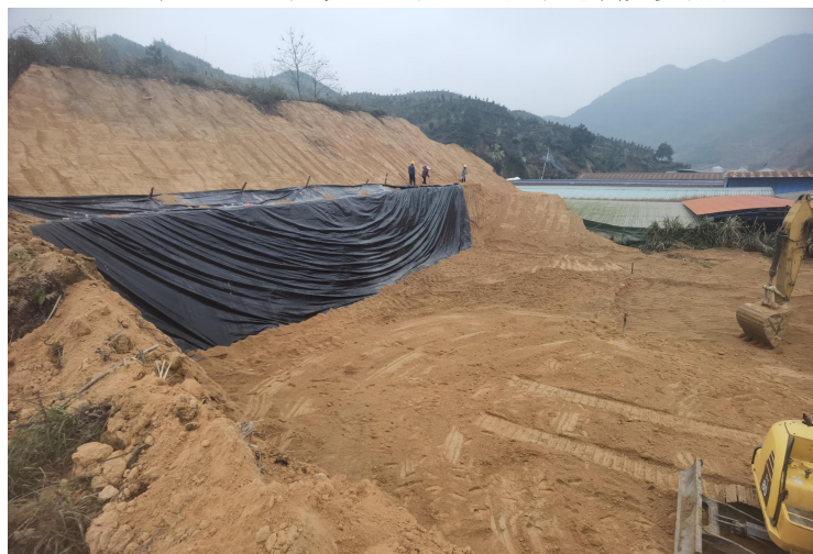
照片 5-53 扎头源表土堆放场修复中
