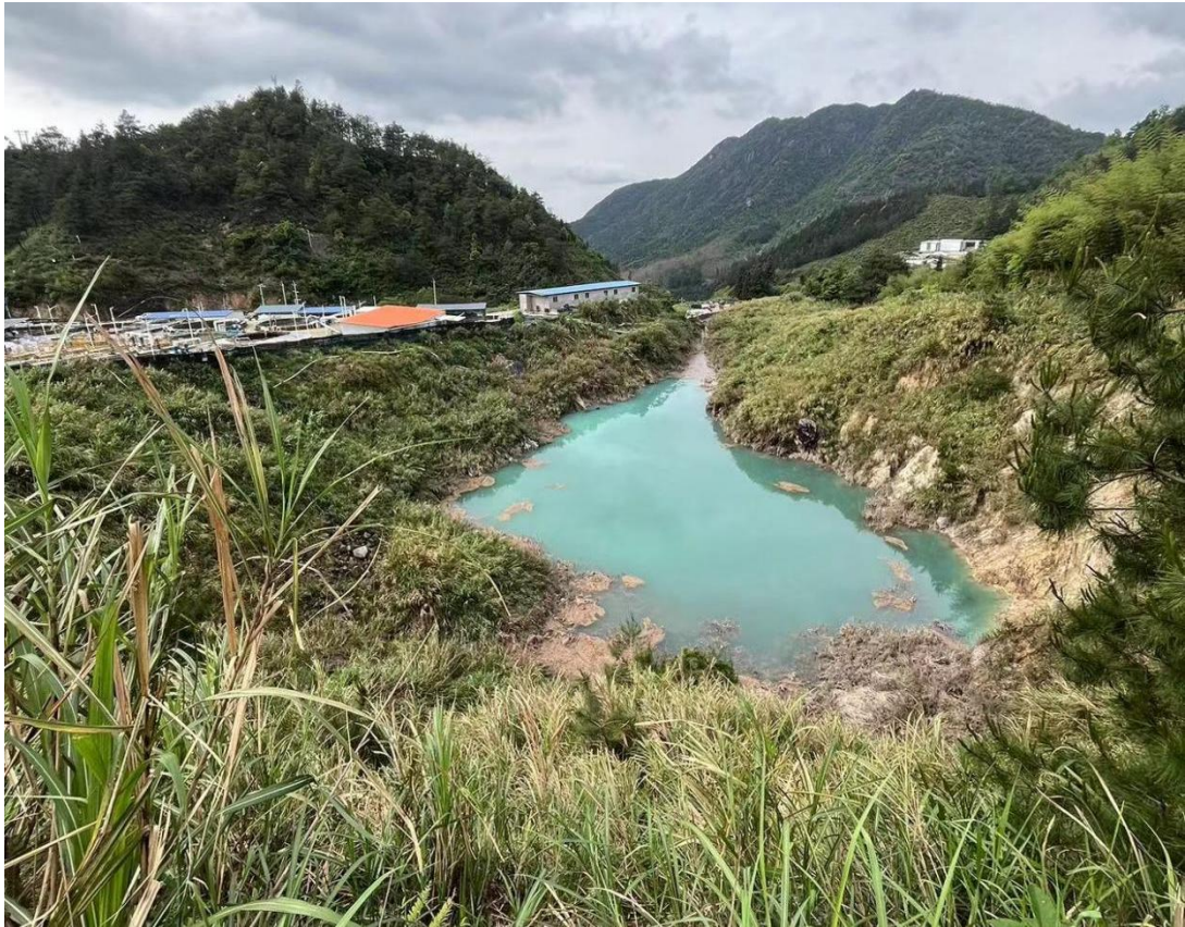
照片 5-49 大观塘铁矿东北原始露采坑现状，已复绿
