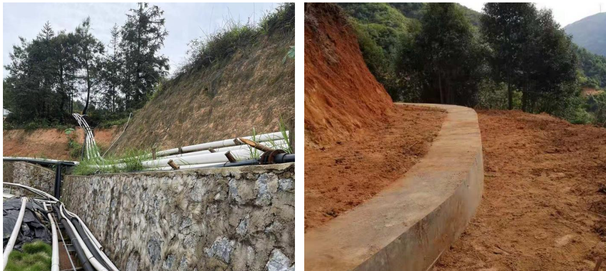
照片 5-24 挡土墙（左）及抗滑桩（右）
