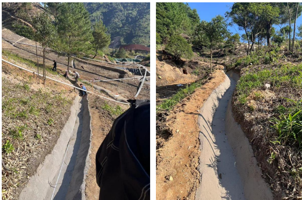
照片 5-55 截排水沟
