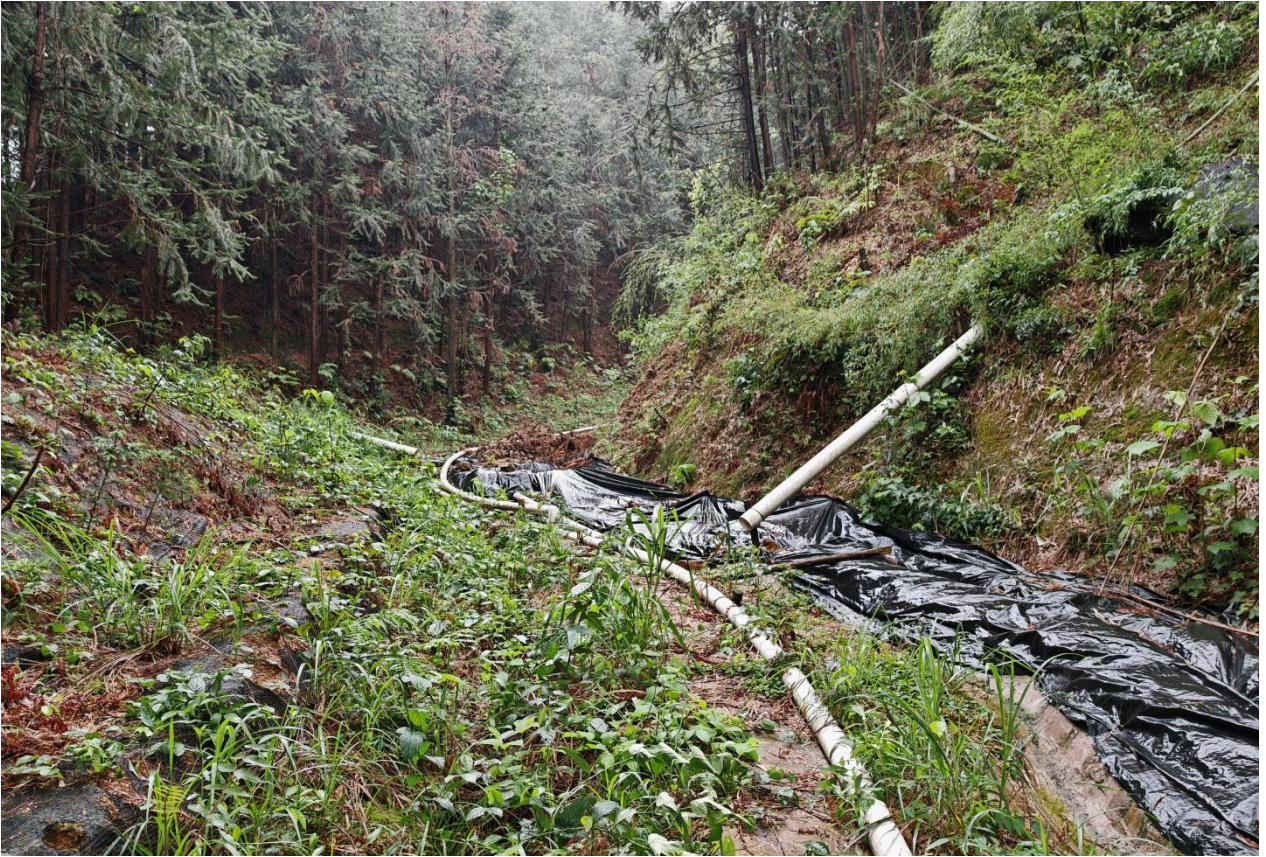
照片 5-64 四工区采场平台复绿
