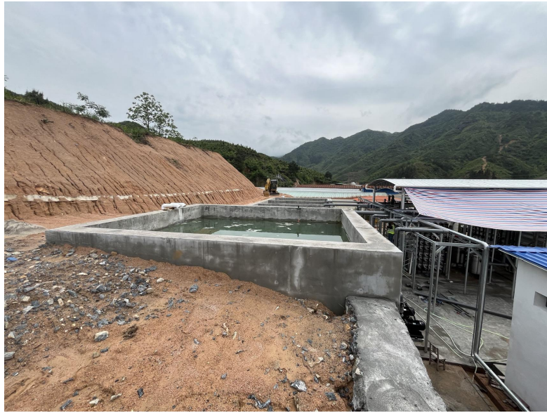
照片 5-54 扎头源表土堆放场修复后
